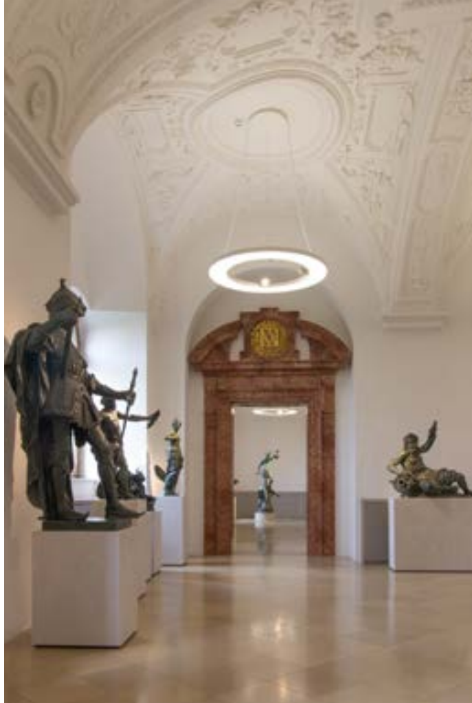
Abb.: Technisch modifiziert präsentiert sich »Anello« auch im Flurbereich. Abstrahlwinkel und Lichtfarbe der LED-Spots lassen sich individuell einstellen.
