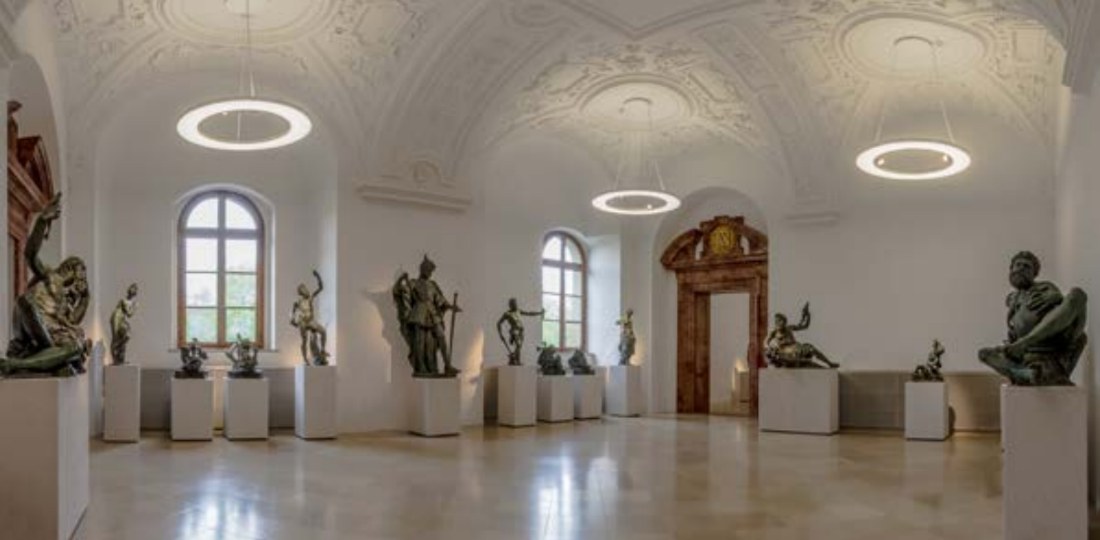
Abb.: Die Bronzesäle der Münchner Residenz werden durch LED-Leuchten »Anello« beleuchtet. Diese geben ein kräftiges Raumlicht ab und können durch Einzelspots individuell auf Exponate eingestellt werden.
