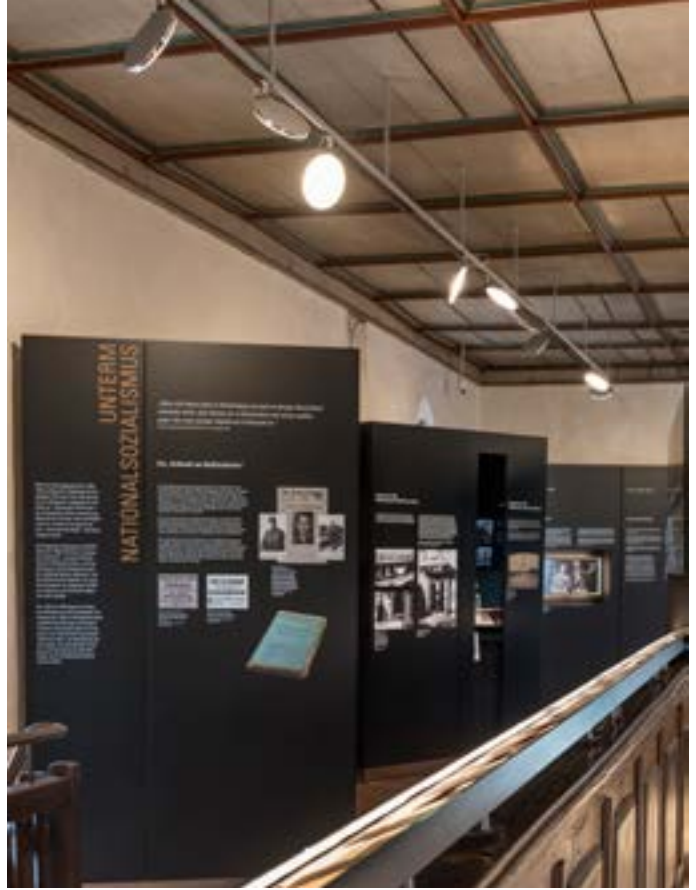
Abb.: Das Schienensystem »Avveni lightlight®« passt sich der Ausstellungssituation gekonnt an. Über Drehen und Kippen und das magnetische Kugelgelenk lassen sich die Leuchtenköpfe individuell ausrichten.
