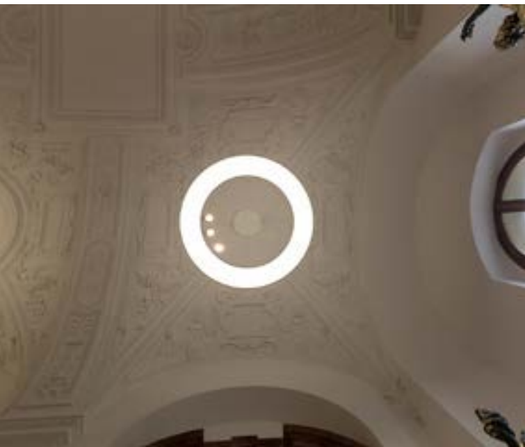
Abb.: Gut zu erkennen sind die drei zusätzlich an der Leuchte angebrachten LED-Strahler, welche die Anforderungen an gerichtetes Licht zur Objektbeleuchtung erfüllen.
